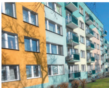
ul. M. Brzeskiej 9 - remont balkonów
