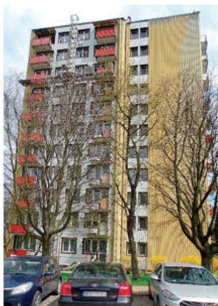
ul. B. Chrobrego 4 - remont balkonów
