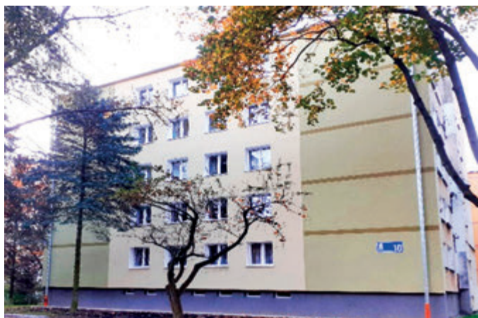
ul. B. Chrobrego 10 - docieplenie ściany północnej
