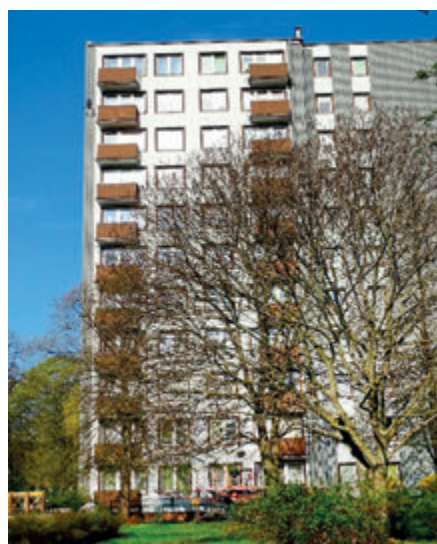
ul. K. Wielkiego 9 - remont balkonów
