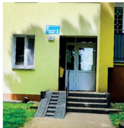
ul. B. Śmiałego 3 - wykonanie podjazdu dla osób niepełnosprawnych
