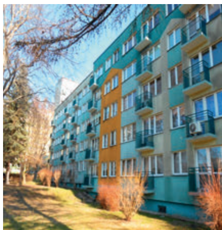
ul. Rzeckiego 4 - remont balkonów
