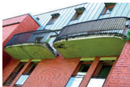
ul. Gliniana 43 - remont balkonów
