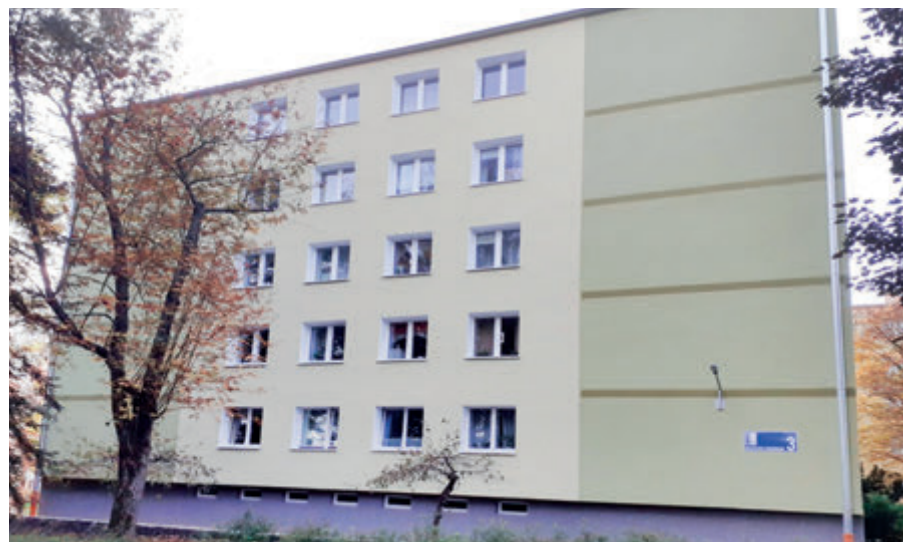
ul. B. Chrobrego 3 - docieplenie ściany północnej
