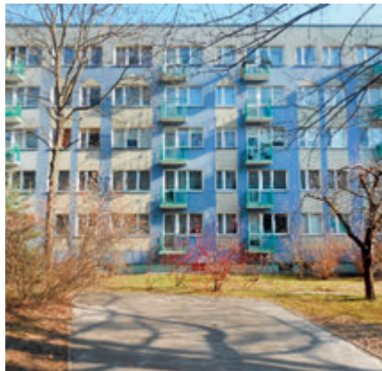
ul. Emancypantek 3 – remont balkonów
