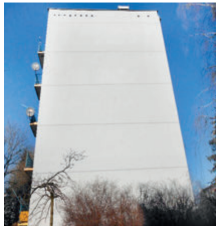
ul. Ochockiego 3 – docieplenie ściany szczytowej
