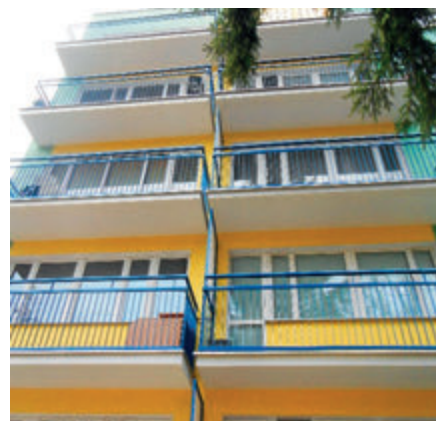
ul. M. Brzeskiej 6 - remont balkonów
