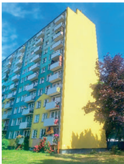
Zdjęcie w trakcie remontu i po ściany szczytowej budynku przy ul. Juranda 5
