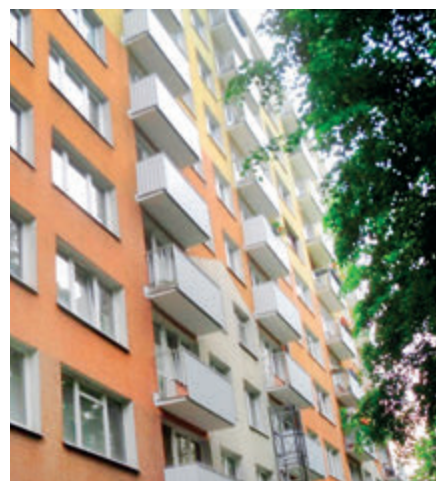
Remont balkonów budynku Juranda 3
