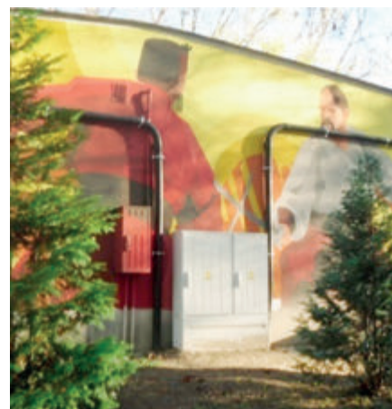
Wymiana instalacji elektrycznej w zespołach garażowych przy ul. Juranda 2, 4, 6, 10
