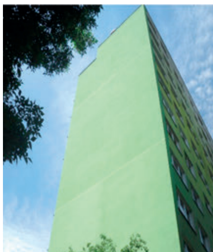
Przed remontem i po remoncie elewacji ściany szczytowej budynku ul. Juranda 1
