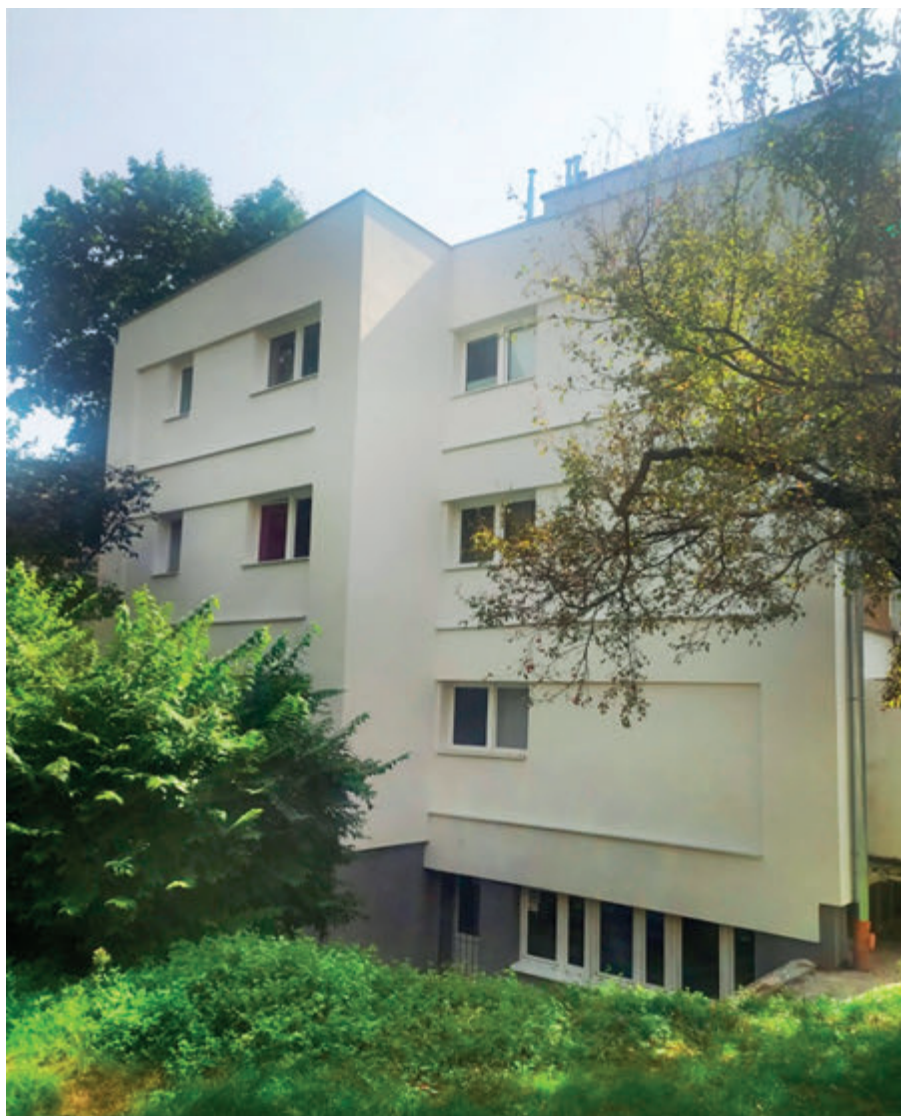
Termomodernizacja budynku ul. Balladyny 20
