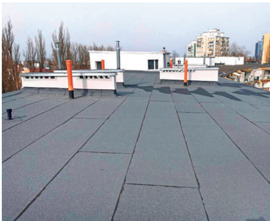
Ocieplenie stropu wraz z nowym pokryciem dachu i remontem kominów, budynek ul. Skierki 1
