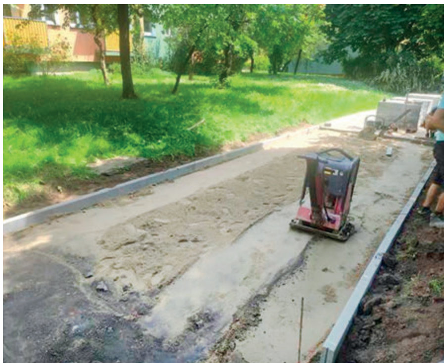
Remont ciągu pieszo „Aleja kasztanowa”
