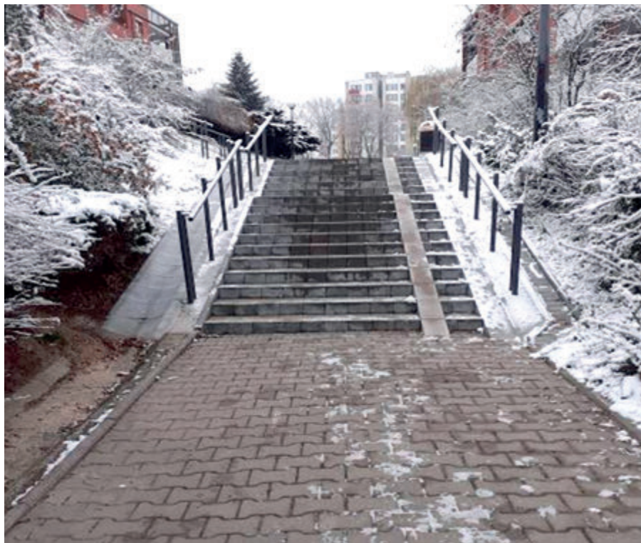
Ul. B. Śmiałego – remont schodów
