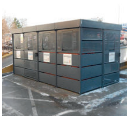
Ul. Nadbystrzycka 101 – nowa altana śmietnikowa
