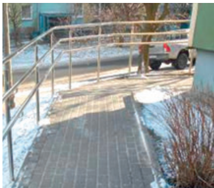
Ul. M. Brzeskiej 5 kl. I i II – wykonanie podjazdu dla osób niepełnosprawnych pod budynek
