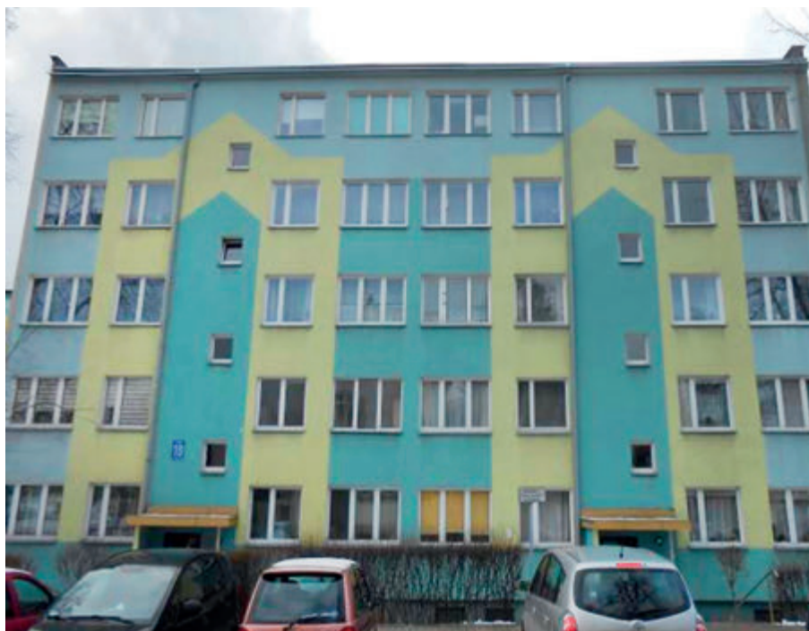
Ul. Rzeckiego 19 – mycie elewacji oraz remont obróbek blacharskich
