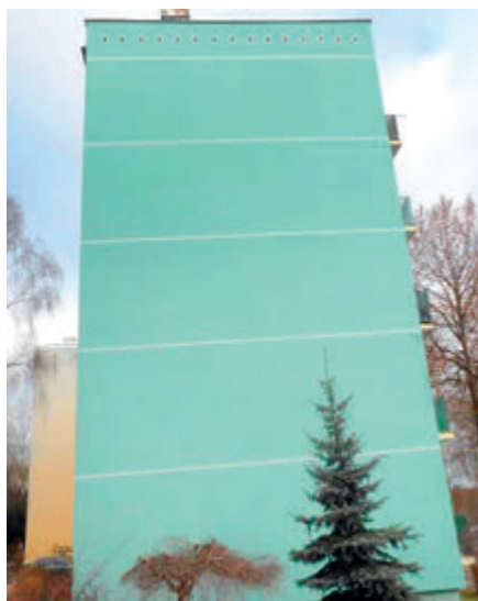
Ul. Ochockiego 6 – docieplenie ściany szczytowej
