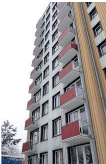
Ul. B. Chrobrego 4 – remont balkonów
