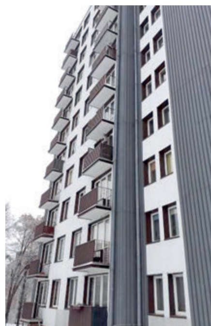
Ul. B. Chrobrego 16 – remont balkonów
