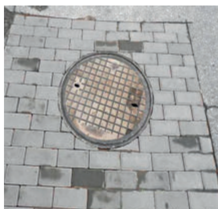
Ul. Nadbystrzycka 103 – regulacja studzienki kanalizacyjnej
