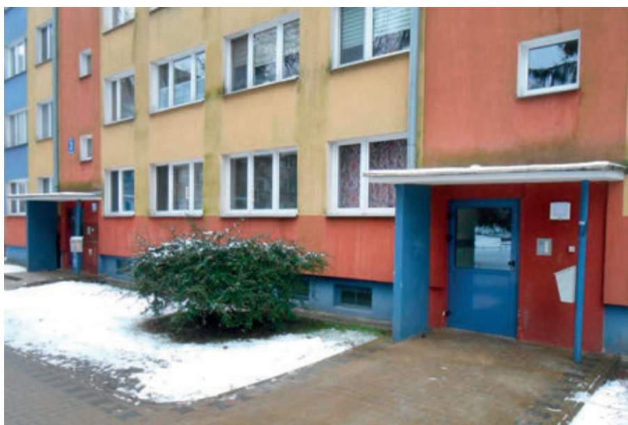
Ul. Pozytywistów 3 – montaż lamp LED z czujnikiem ruchu
