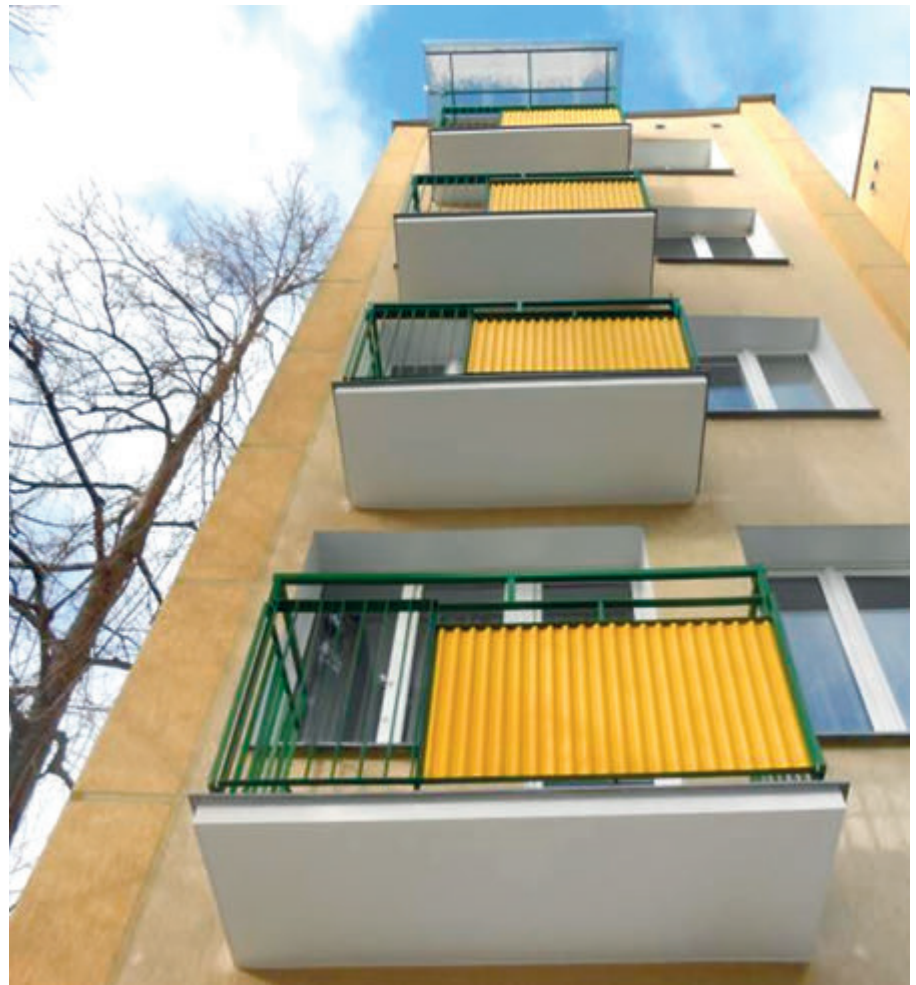
Ul. Pozytywistów 20 – remont balkonów
