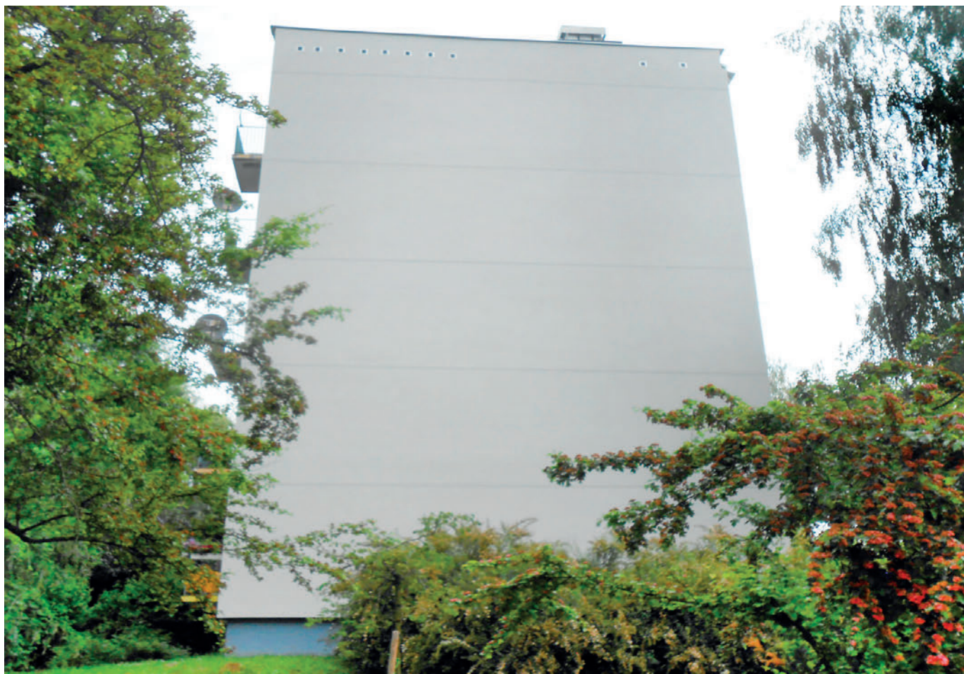
Ul. Ochockiego 3, docieplenie ściany szczytowej
