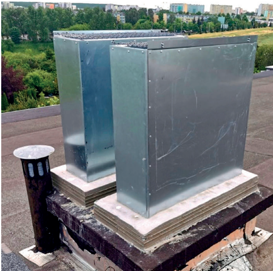
Ul. K. Wielkiego 1, montaż nasad kominowych
