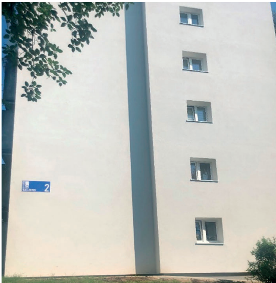
Balladyny 2 wykonane docieplenie ściany szczytowej
