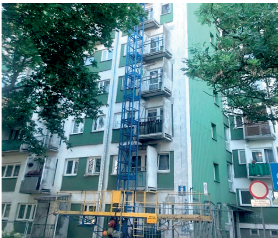
Wzmocnienie konstrukcji balkonów wieżowce Zana/Wileńska
