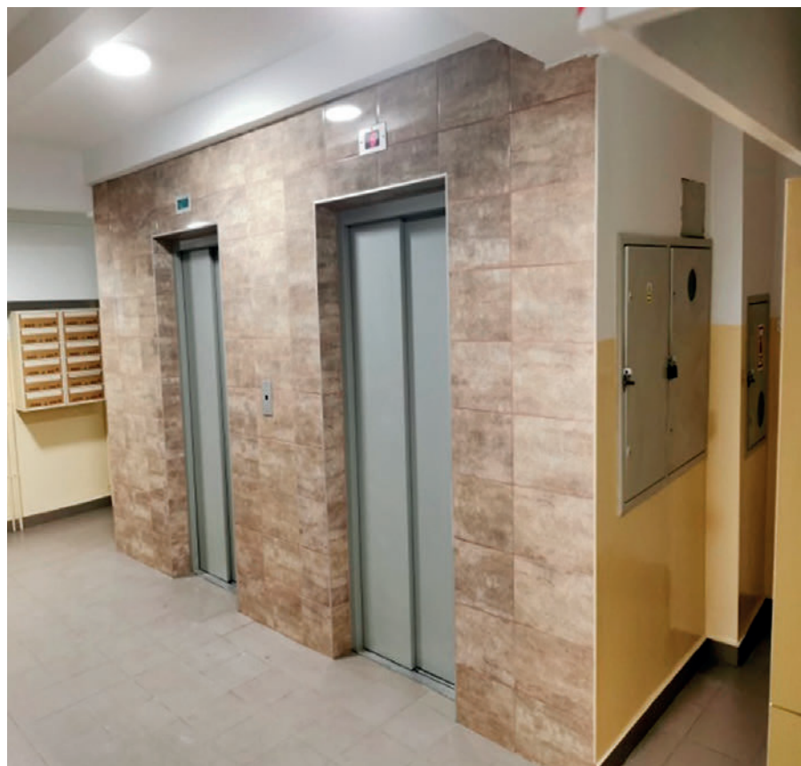
Ul. K. Wielkiego 13, remont parteru
