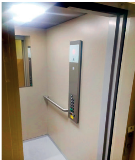
Zrealizowana inwestycja wymiany windy, Kasińskiego 16 II klatka
