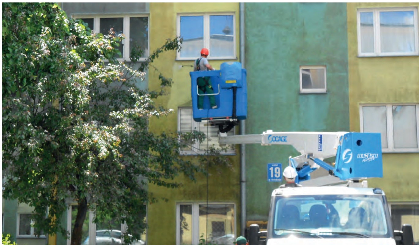
Mycie elewacji budynku ul. Rzeckiego 19
