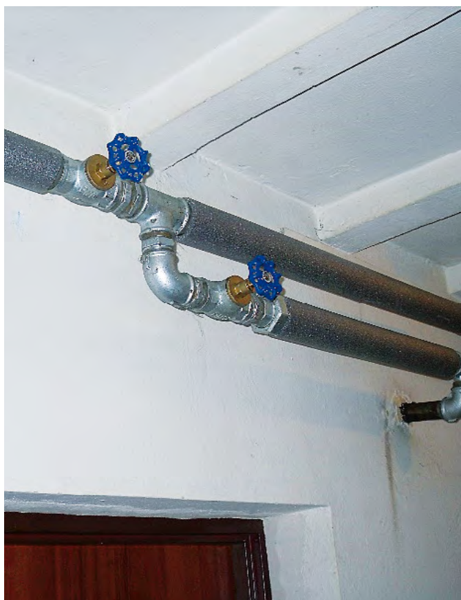
wymiana instalacji wodociągowej Zana 8
