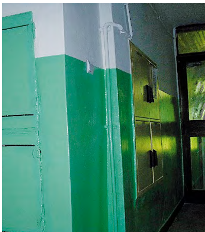
malowanie klatki schodowej Balladyny 2 kl. VIII
