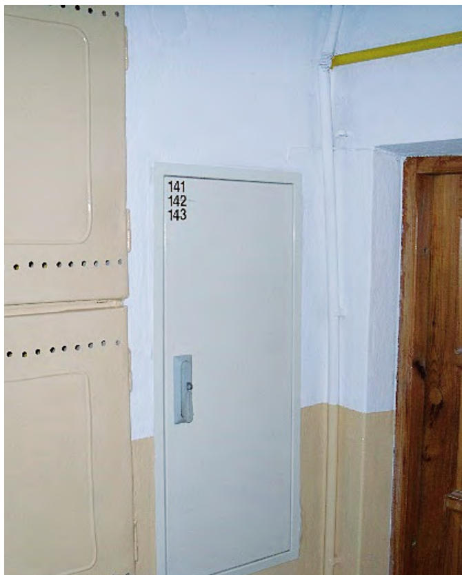
malowanie klatki schodowej Balladyny 12 kl. XII
