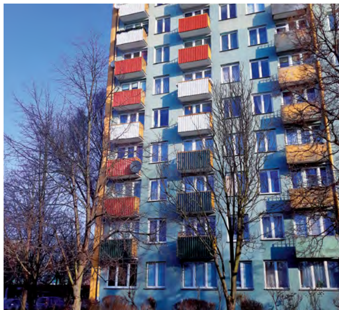
Wyremontowane balkony w budynku przy ul. Skrzetuskiego 10
