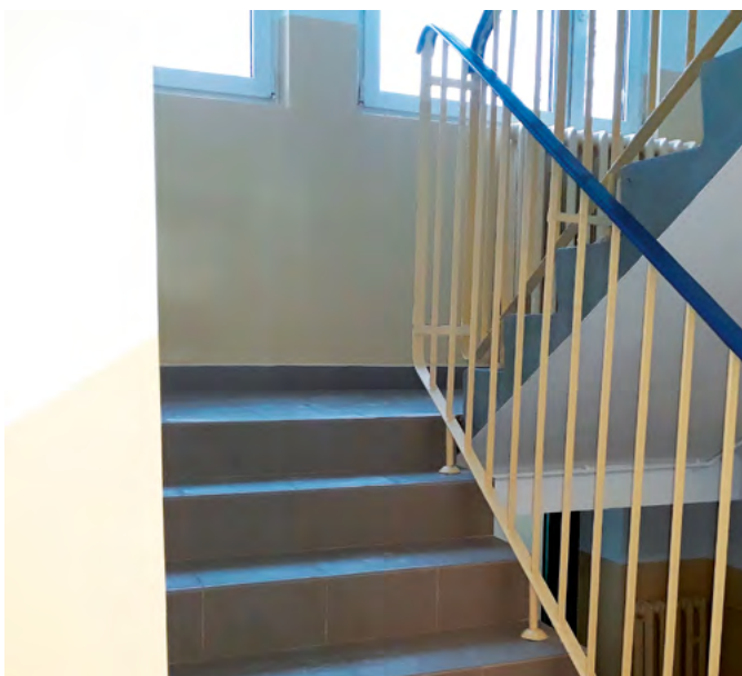
Przykład wyremontowanej klatki schodowej w budynku przy ul. Juranda 1.
