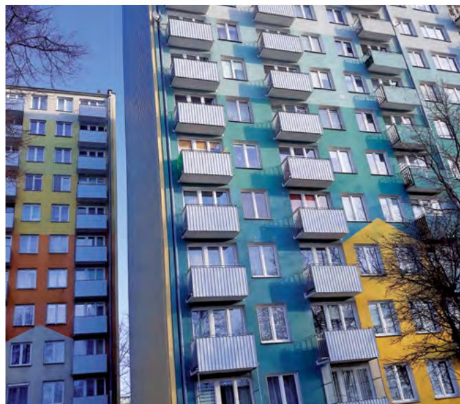
Wyremontowane balkony w budynku przy ul. Juranda 5
