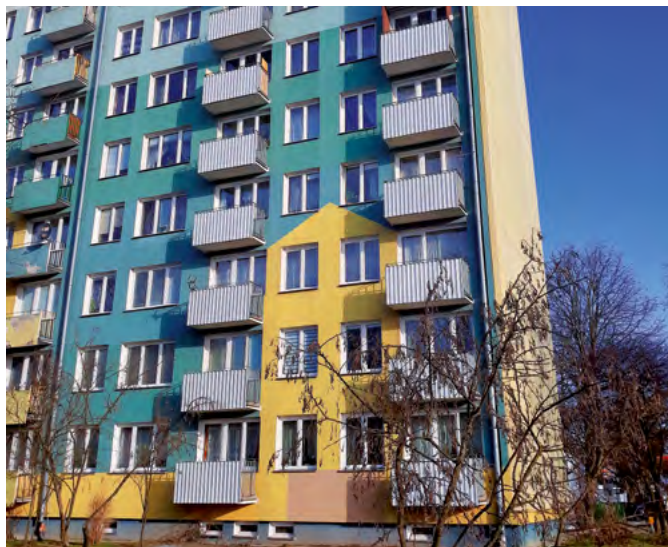
Wyremontowane balkony w budynku przy ul. Juranda 3
