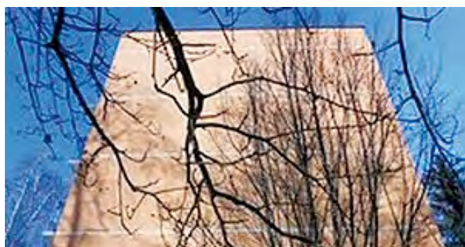
Docieplenie ściany szczytowej Emancypantek 5
