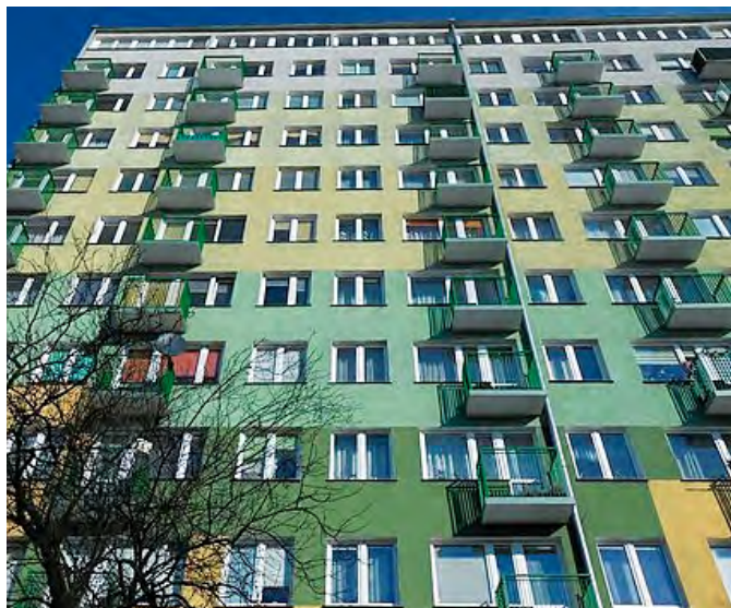
Remont balkonów Rzeckiego 3
