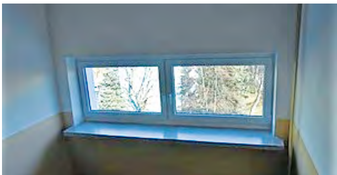
Wymiana okien na klatce schodowej ul. M. Brzeskiej 12
