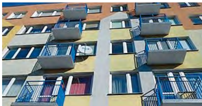
Remont balkonów Emancypantek 5
