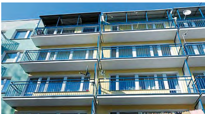
Remont balkonów M. Brzeskiej 6
