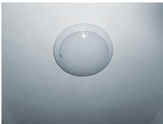
Wymiana opraw oświetleniowych M. Brzeskiej 5
