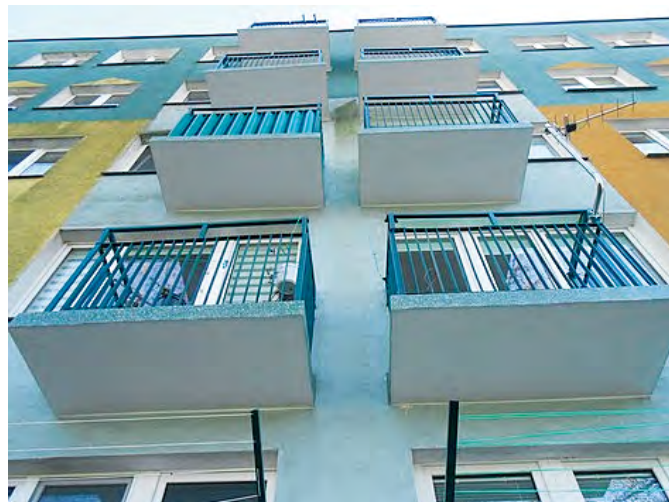
Remont balkonów Rzeckiego 4
