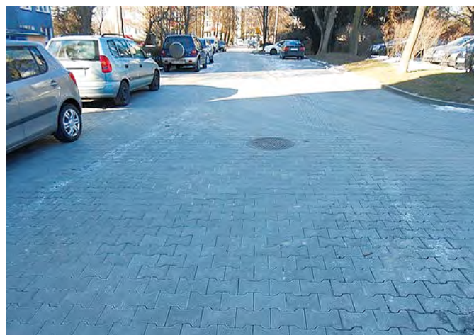
Remont nawierzchni ciągu pieszo – jezdni ul. Pozytywistów 6 – ul. M. Brzeskiej 15
