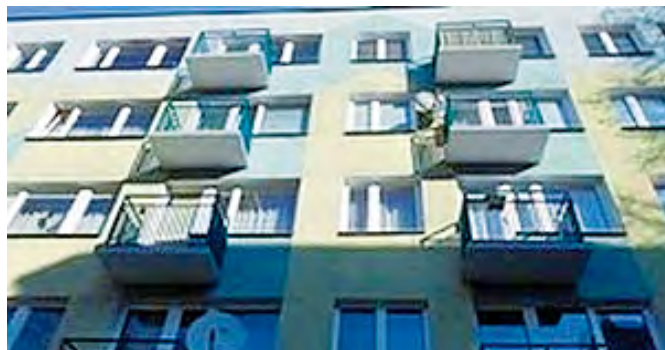
Remont balkonów Rzeckiego 19
