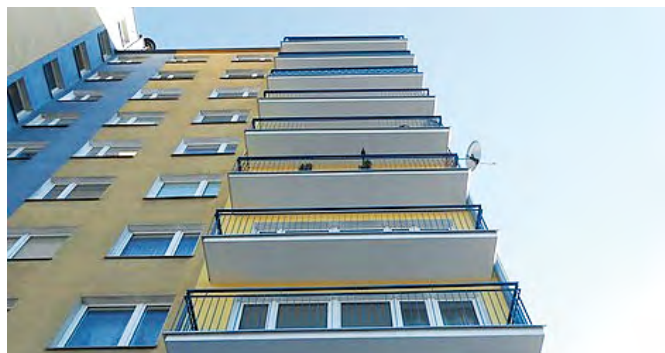
Remont balkonów Nadbystrzycka 85
