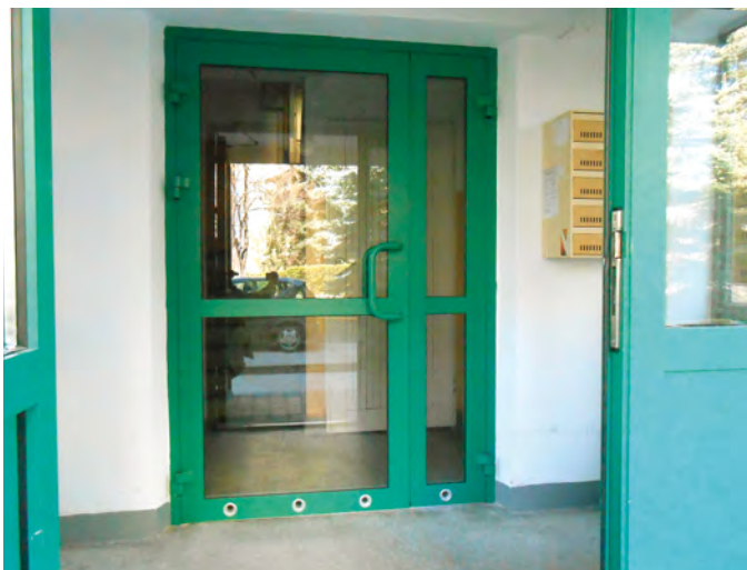
Wymiana drzwi wewnętrznych M. Brzeskiej 10
