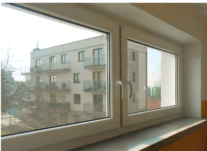
Wymiana okien na klatce schodowej Nadbystrzycka 101
