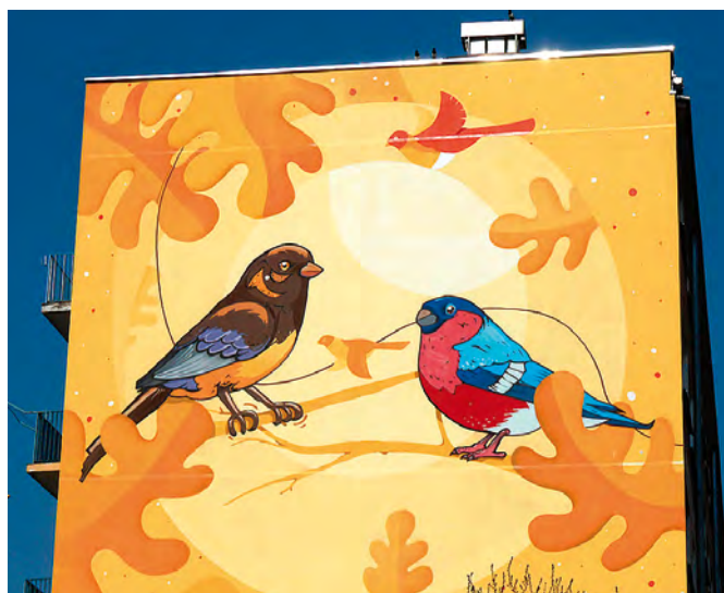
Docieplenie ściany szczytowej Ochockiego 5 oraz mural
