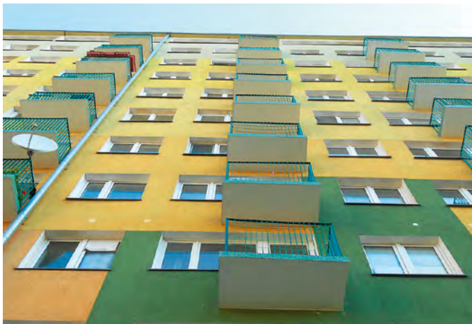
Remont balkonów M. Brzeskiej 5
