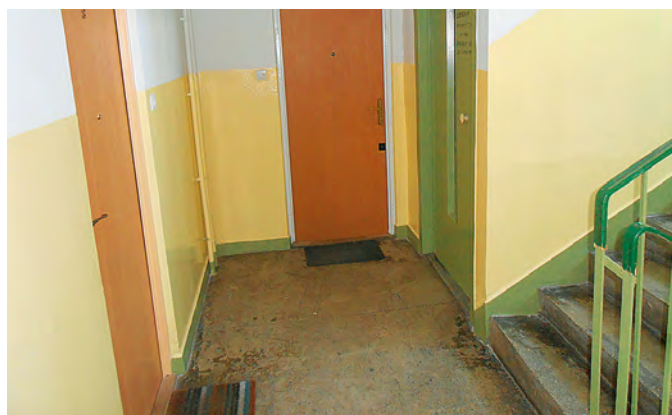
Malowanie klatki schodowej Pozytywistów 4
