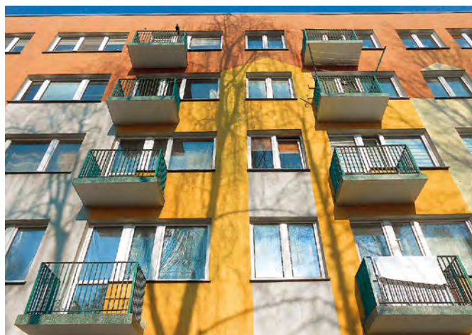
Remont balkonów Ochockiego 4
