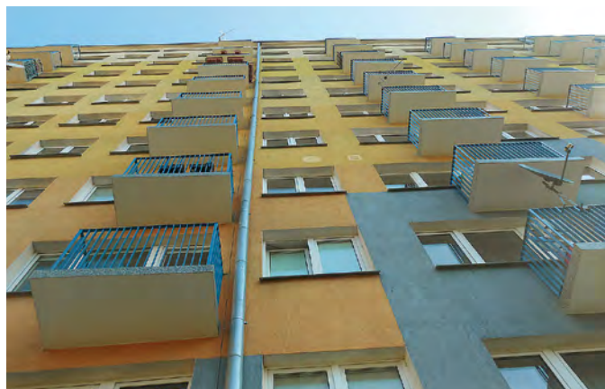
Remont balkonów Pozytywistów 2
