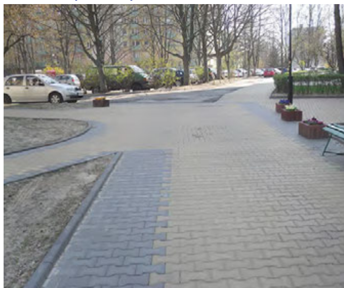
g. Żarnowiecka 5 – remont nawierzchni z wymianą na kostkę brukową 570 m 2 .
