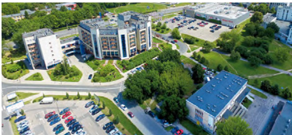
Osiedle im. H. Sienkiewicza widok na zespół budynków przy ulicy Tomasza Zana 27 i 29.
