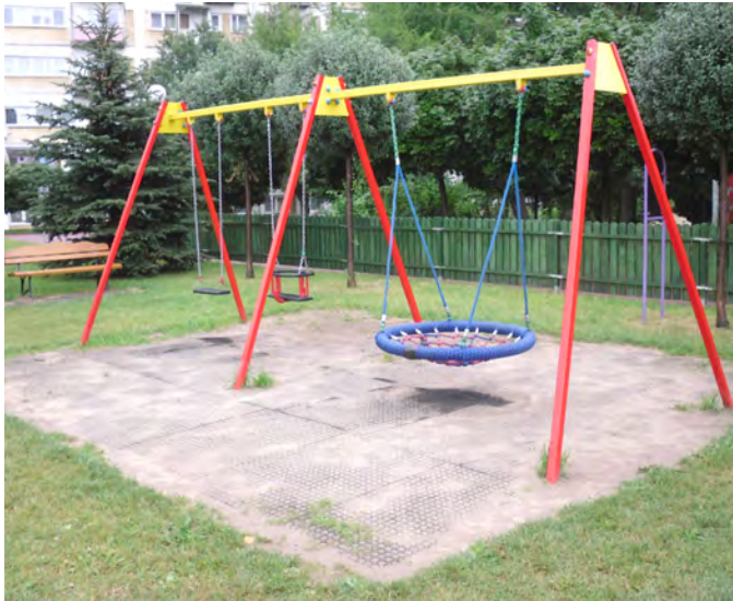
Remont nawierzchni na placu zabaw
