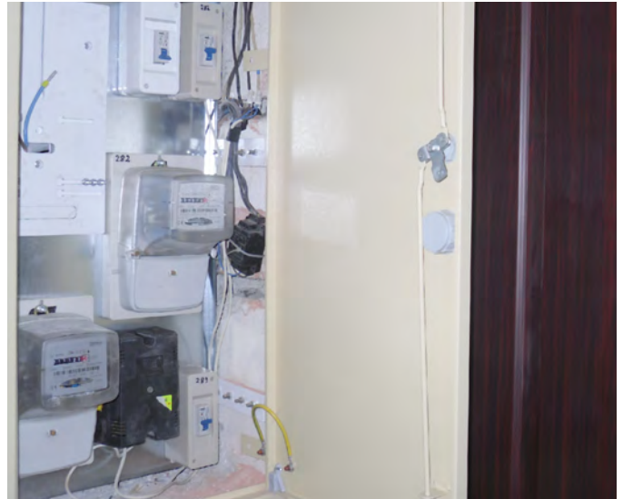
Remont tablic elektrycznych ul. Balladyny 12
