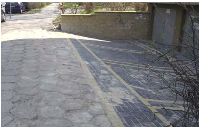
Remont dojazdów do garaży Wallenroda 6 i 8
