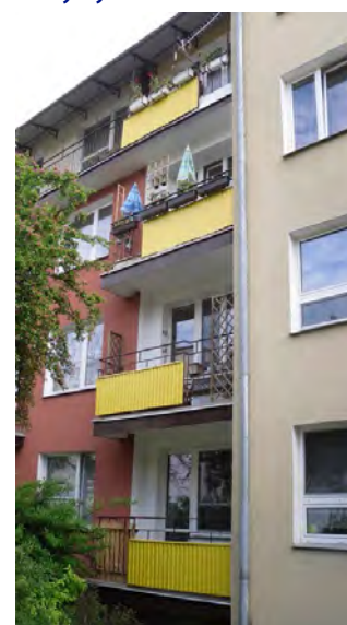
Remont balkonów Grażyny 21
