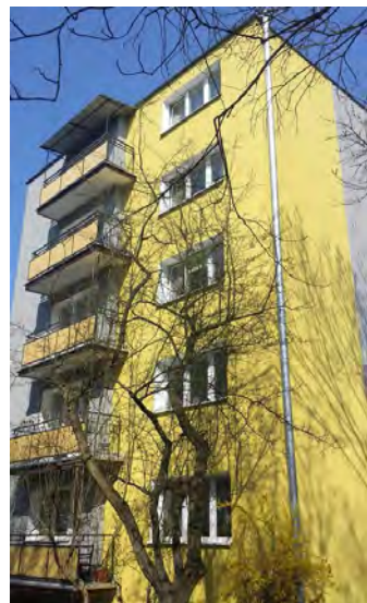
Docieplenie ściany szczytowej Wajdeloty 10
