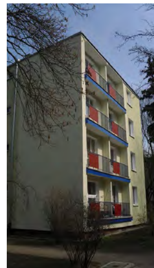
Termomodernizacja wraz z remontem balkonów Grażyny 14
