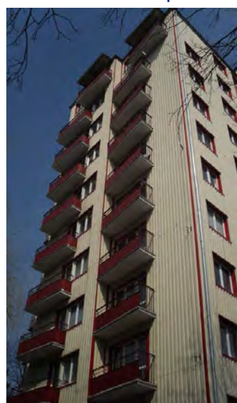
Remont balkonów Rymwida 6
