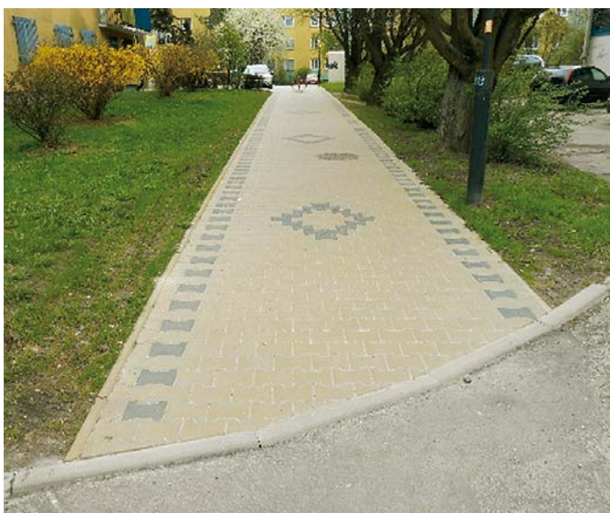
Remont chodnika Nadbystrzycka 87
