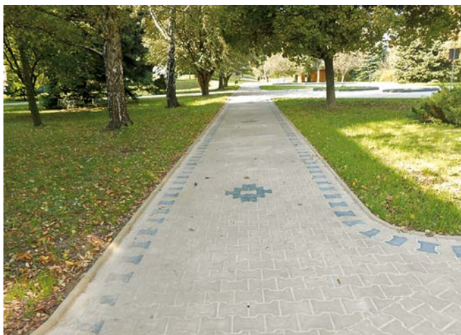
Remont placu i alejek – kostka brukowa – Nadbystrzycka 91, 93
