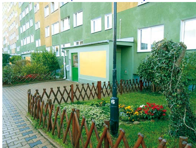
Malowanie wejść do budynku M. Brzeskiej 5
