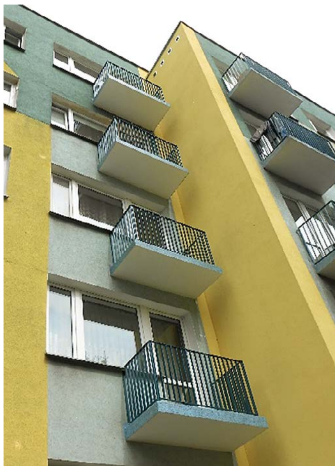
Docieplenie ściany szczytowej i remont balkonów - Rzeckiego 14
