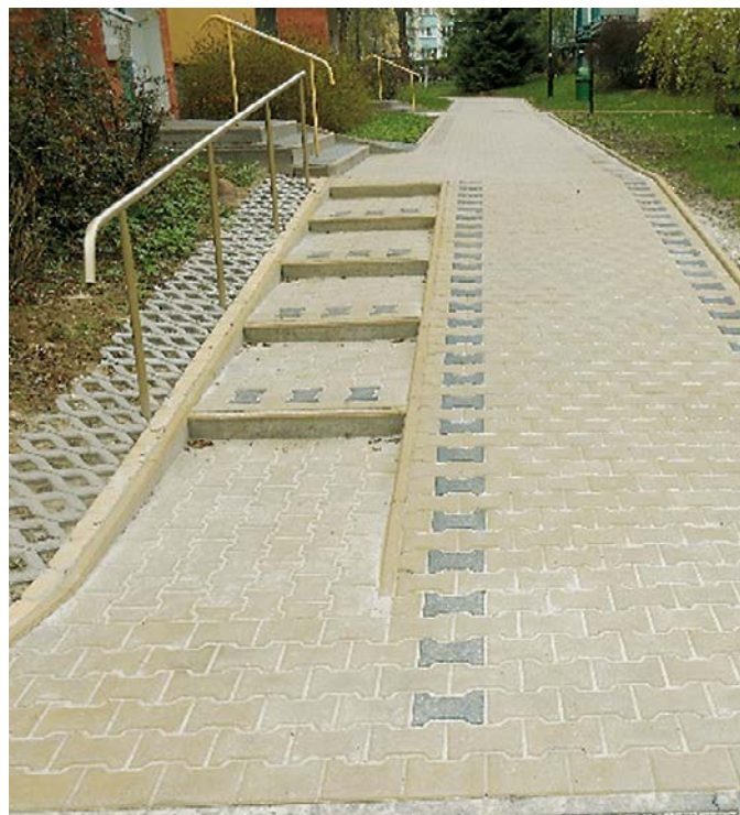
Remont chodników M. Brzeskiej 16
