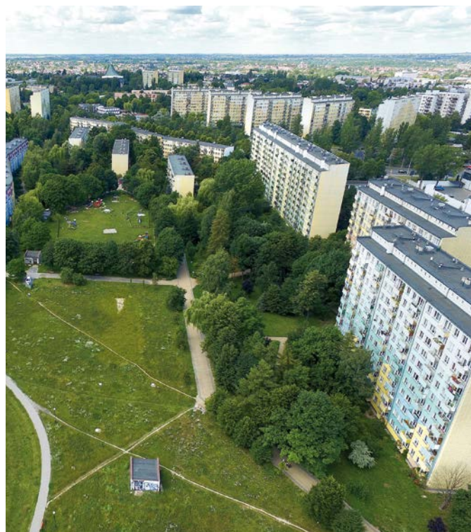
Osiedle im. H. Sienkiewicza widok m. in. na budynki przy ulicy Pana Wołodjowskiego 3, 6, 7, 9, 11.
