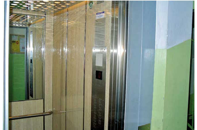
Zmodernizowana winda w budynku przy ulicy Juranda 3.
