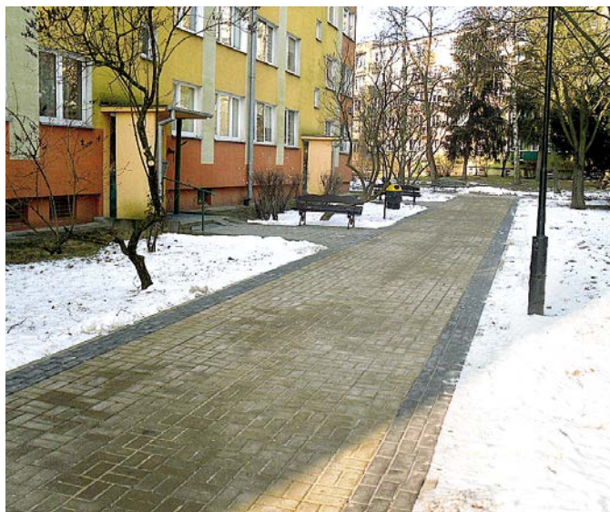
Nowa nawierzchnia ciągu pieszego przy budynku przy ulicy Jana Skrzetuskiego 2A.
