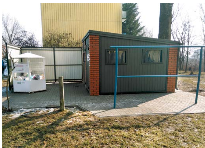
Wyremontowana altana śmietnikowa przy ulicy Pana Wołodjowskiego 9 i 11.
