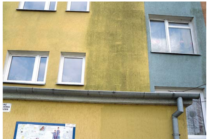
Czyszczenie elewacji budynku przy ulicy Juranda 3.
