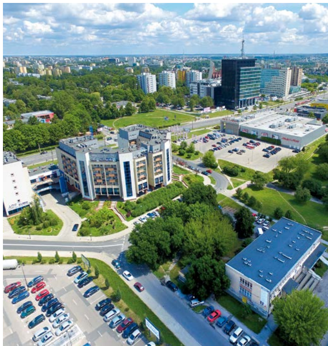
Osiedle im. H. Sienkiewicza widok na zespół budynków przy ulicy Tomasza Zana 27 i 29.
