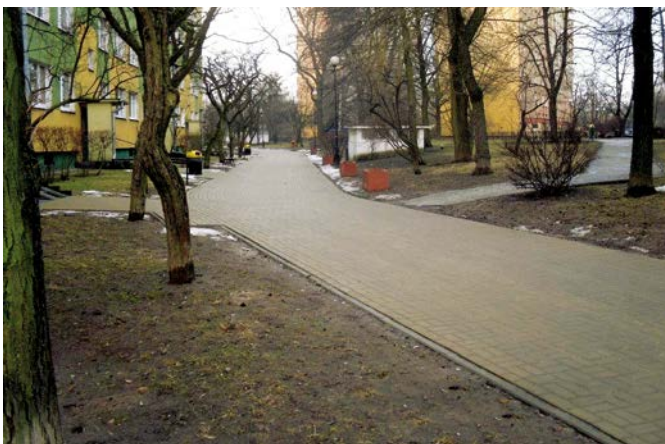
Wymieniona nawierzchnia ciągu pieszego przy budynku przy ulicy Pana Wołodyjowskiego 3.
