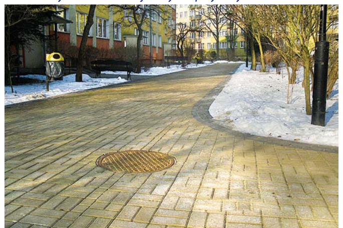
Nowa nawierzchnia ciągu pieszego przy budynku przy ulicy Jana Skrzetuskiego 2B.
