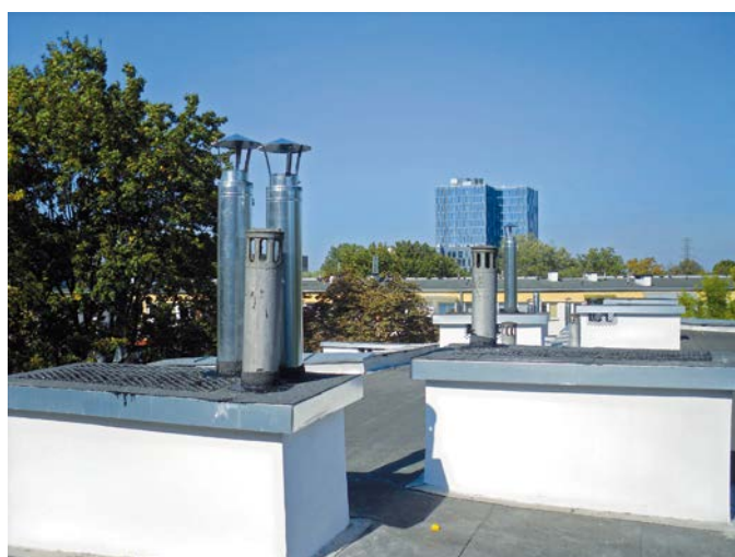
Remont kominów przy ulicy Balladyny 16
