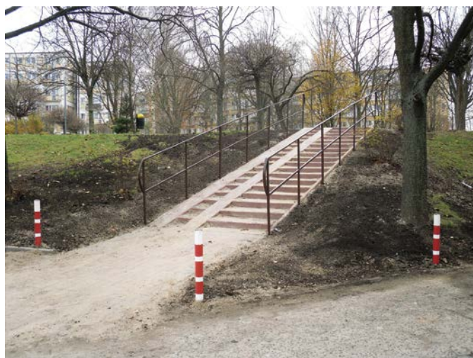
Wyremontowane schody przy pomniku J. Słowackiego
